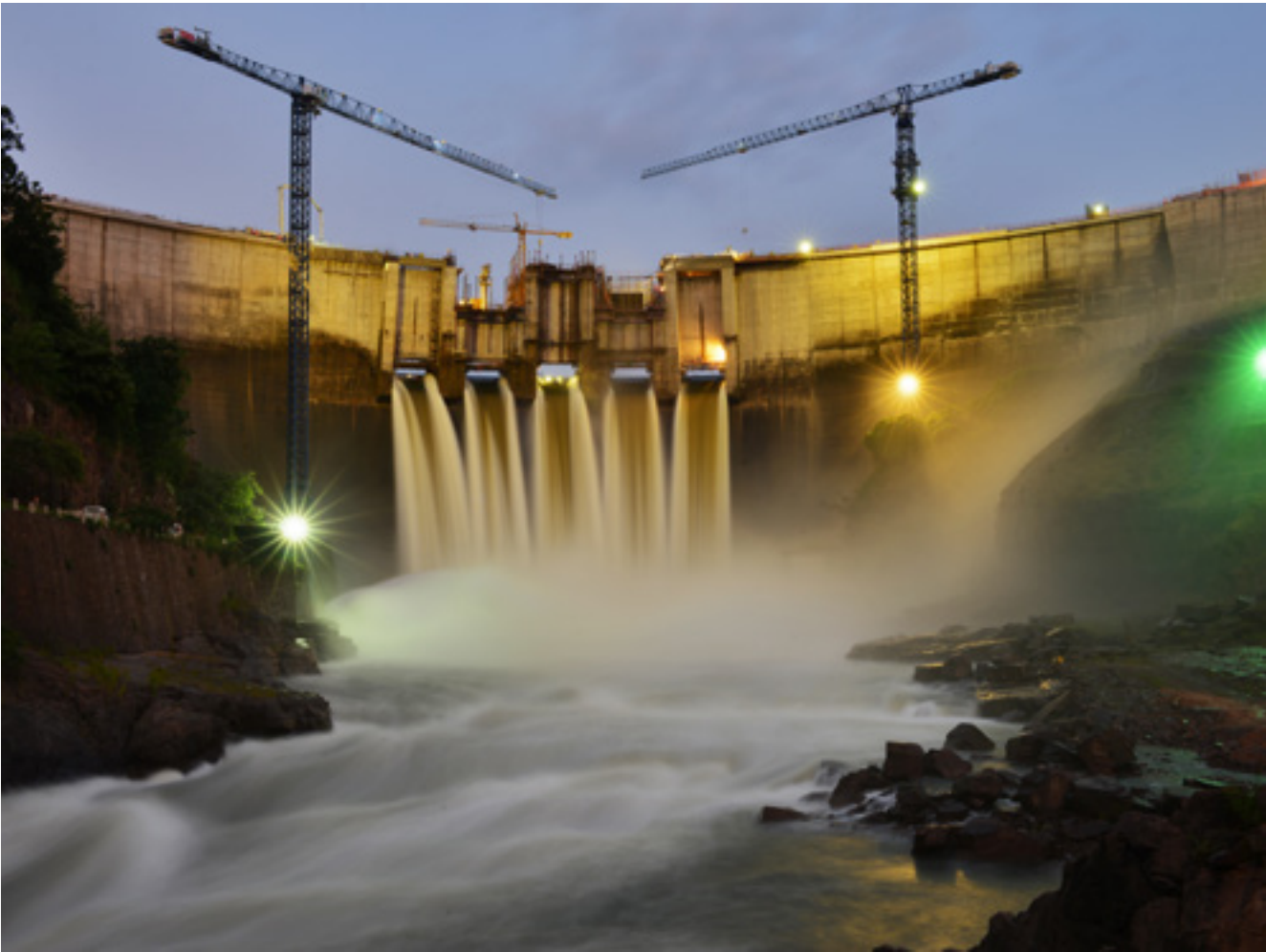
Reformada pela Odebrecht, a Hidrelétrica de Cambambe, em Angola, tem capacidade para gerar 180 MW
