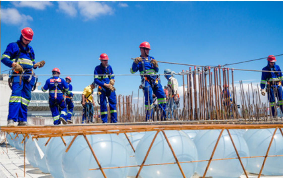
A tecnologia Bubbledeck foi utilizada nas lajes do Centro Administrativo do Distrito Federal
